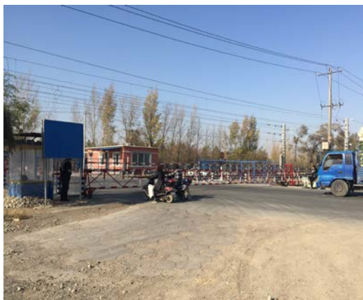
现有道路与铁路交叉口
