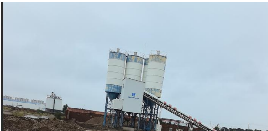
现有搅拌站情况
